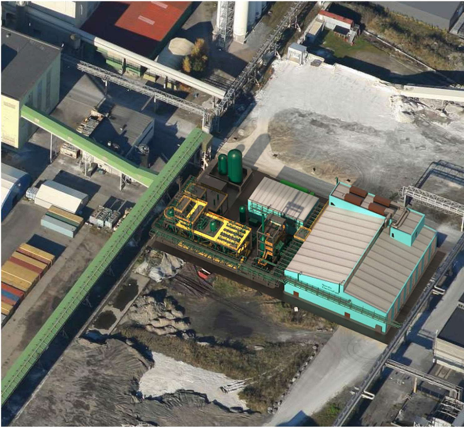
Bilde av anlegget på Herøya Industripark
