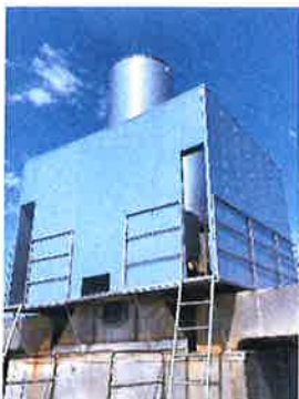
Bildet viser støyvegger som ble montert i 2019 på PM6.
