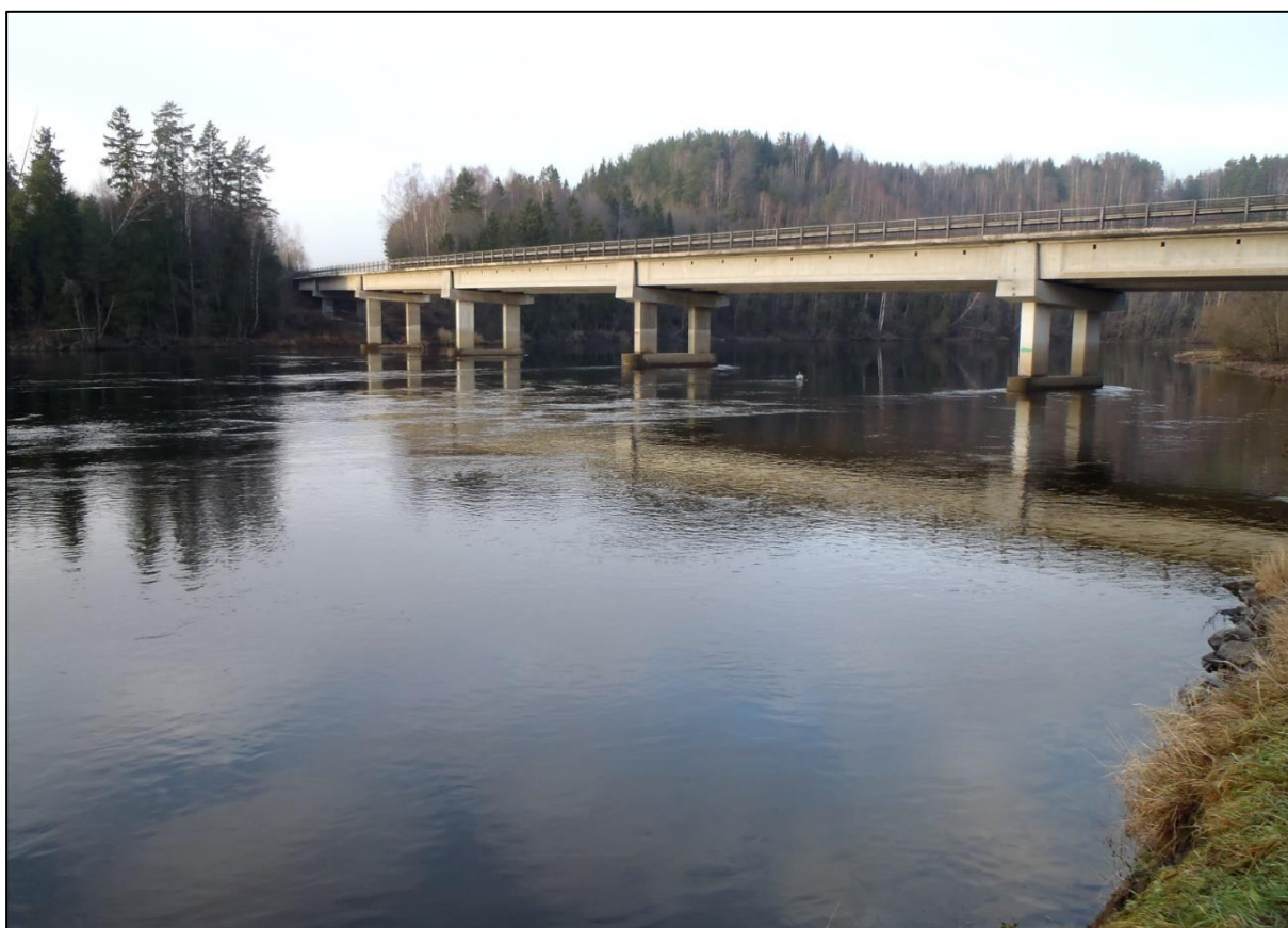
Storelva nedstrøms Storelva bru, ved Monserud renseanlegg. Foto: COWI.
