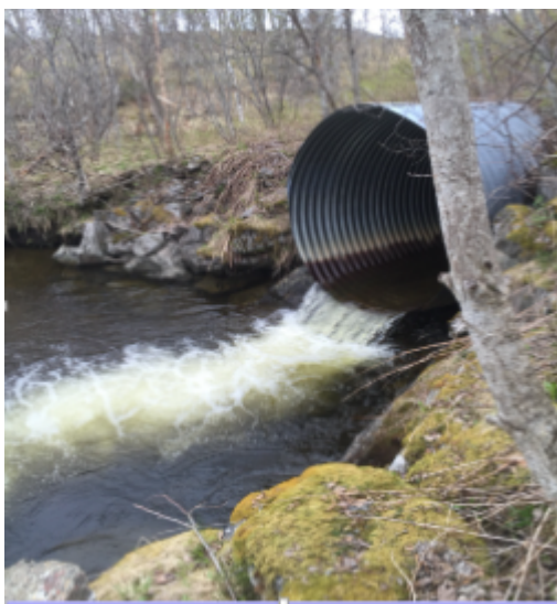
Bildet viser røret som er hevet, slik at fisk ikke kan gå opp i Medbyelva.
